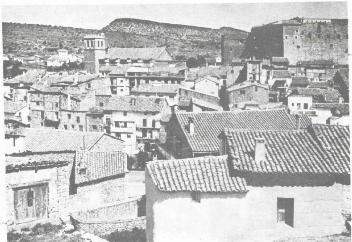
Panorámica de la Villa
